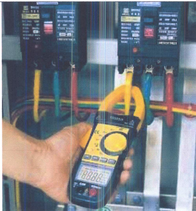
Ilustrasi Pemeriksaan menggunakan Clamp Meter
